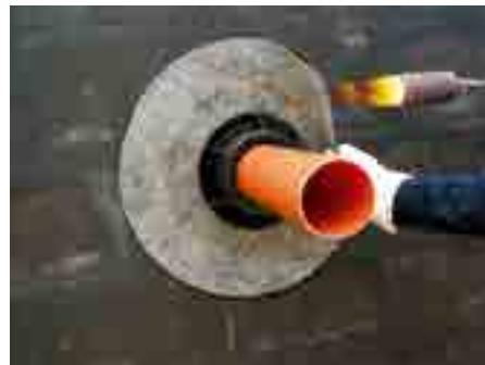
5. Bitumenbahn anflämmen
