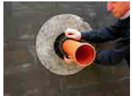
6. Sicherheitsmutter festziehen
