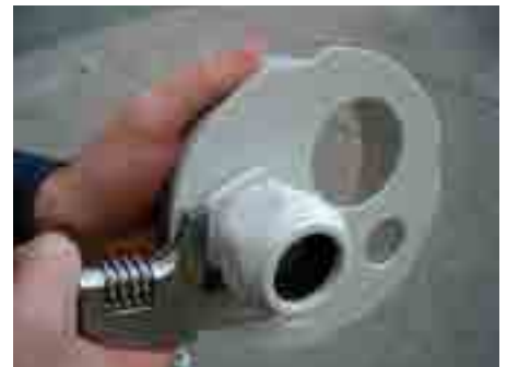
3. Verschraubungen und Rohrdurchführung verbinden, Verschraubungen festziehen
